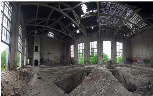
Сграда на локална отоплителна станция, до метростанцията „Г. М. Димитров“
